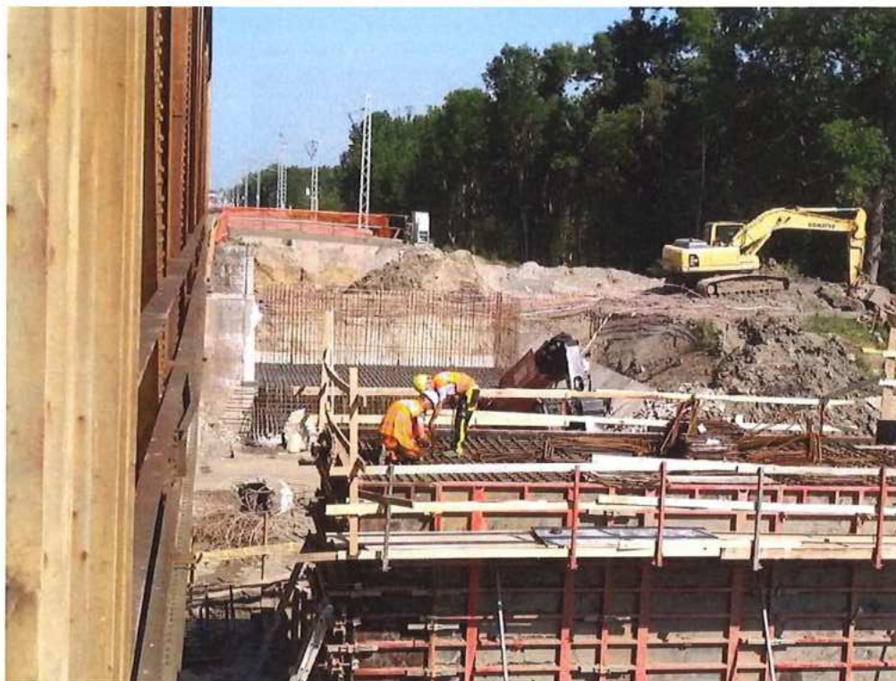
Armovanie a debnenie piliera P2 na strane CZ – SO 12-33-04
