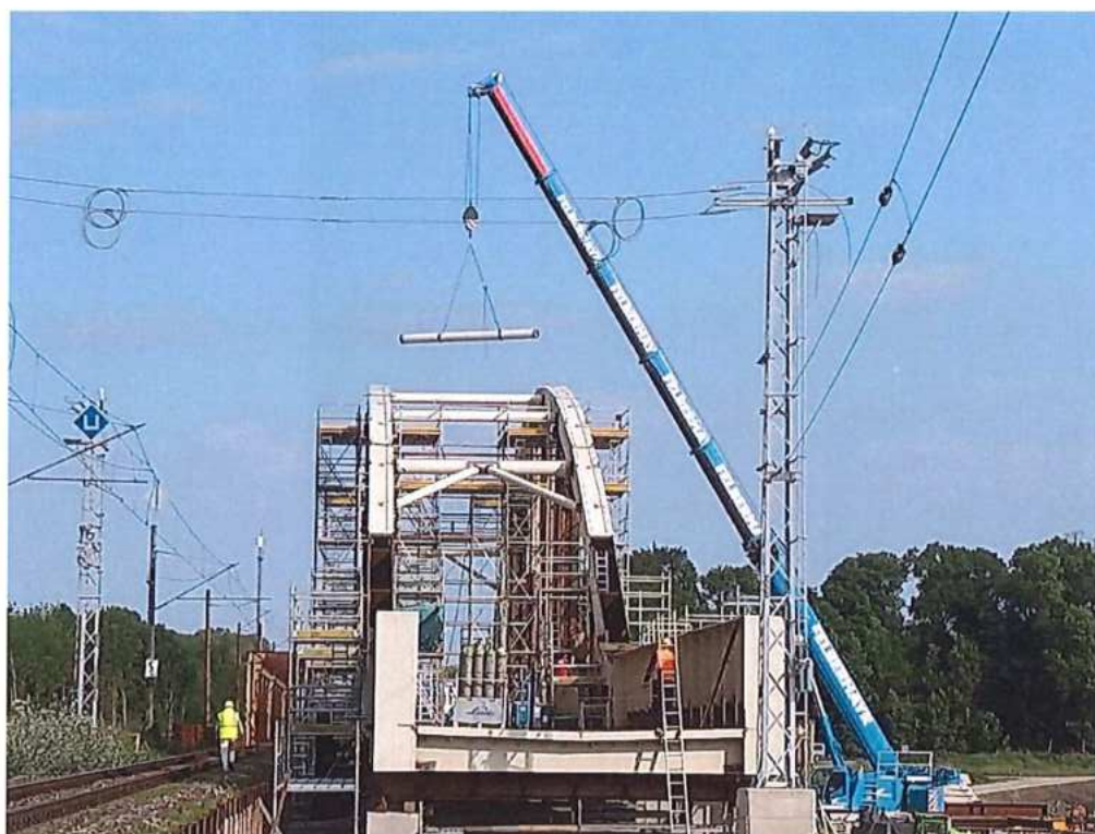
Montáž oceľovej konštrukcie mosta - SO 12-33-04
