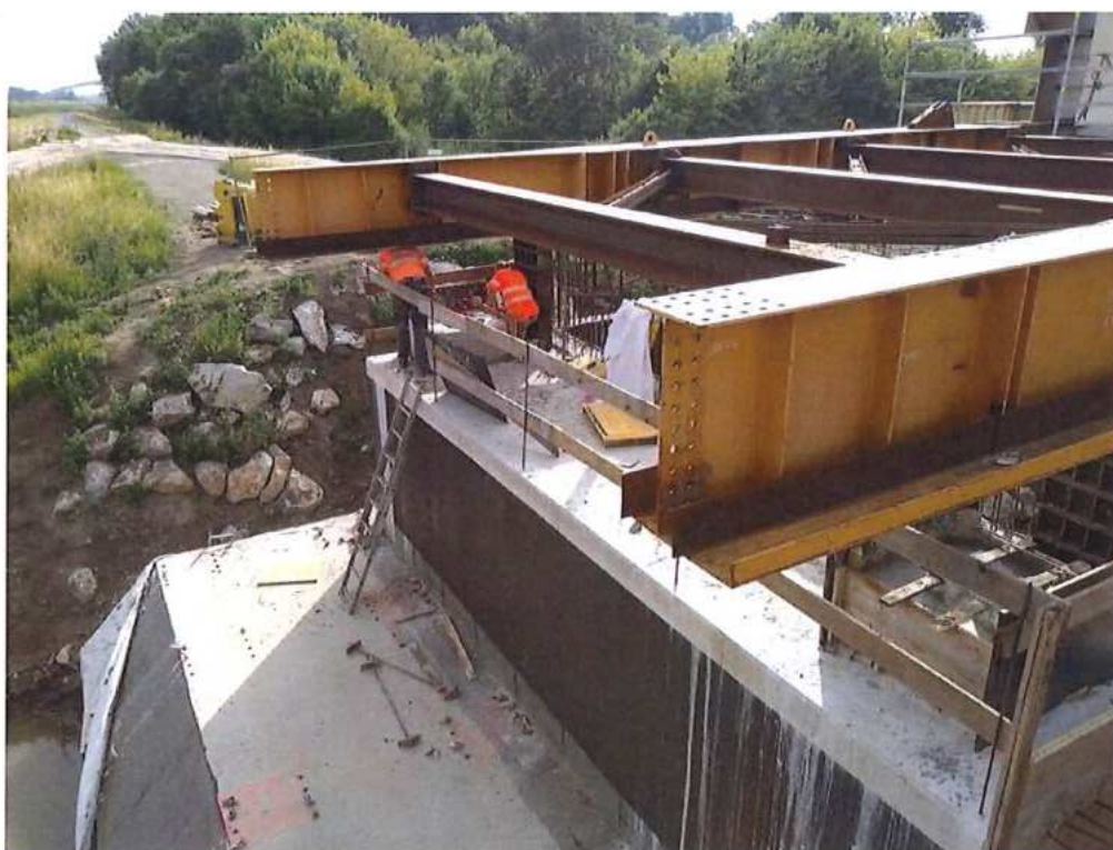
Betonáž podložkových bločkov na opore OP1 na strane SK a montáž výsuvného nosa – SO 12-33-04
