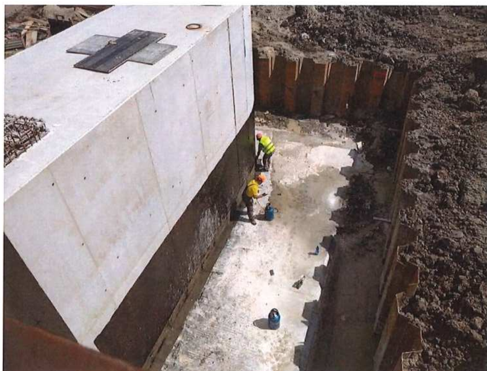
Penetračný náter a izolácie piliera P2 na strane CZ – SO 12-33-04
