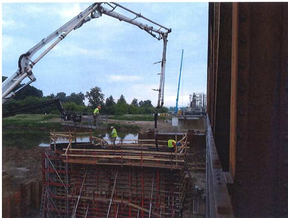
Betonáž piliera P2 na strane CZ – SO 12-33-04
