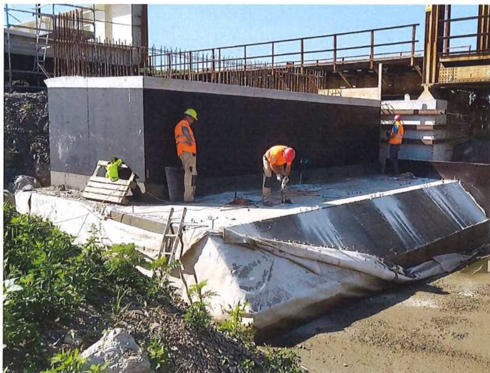
Príprava kotvenia na pilieri P1 pre pomocné zariadenie na výsun mosta
