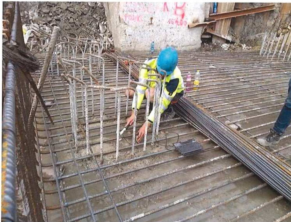
Skúška integrity pilót na opore OP2 na strane CZ – SO 12-33-04
