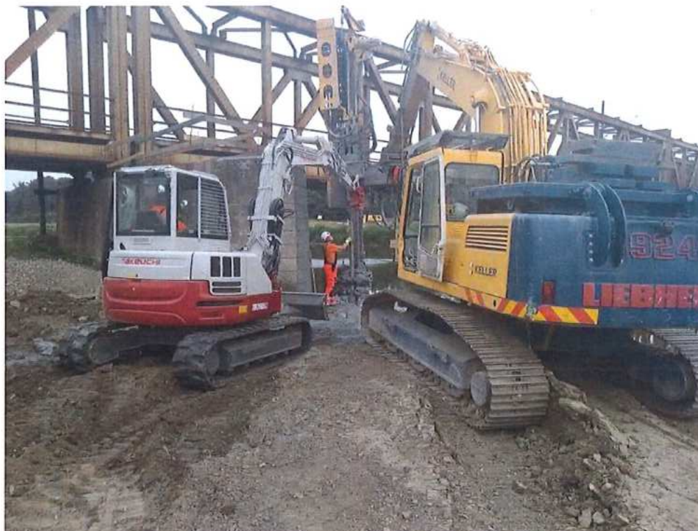
Zriadenie mikropilót pri starom pilieri P1 most Morava 74,386
