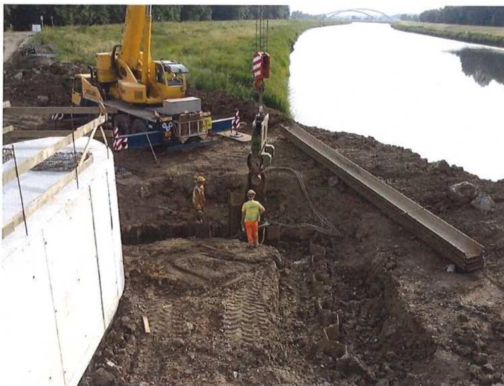
Odstránenie štetovnic pri pilieri P2 na strane CZ – SO 12-33-04
