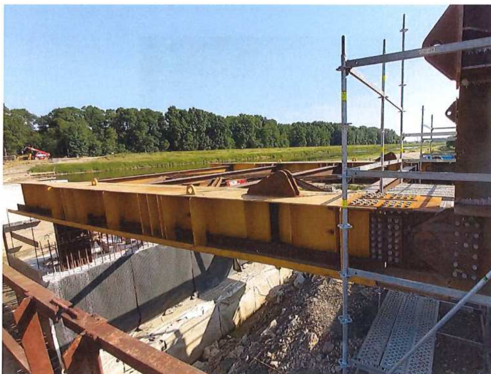
Montáž výsuvného nosa – SO 12-33-04
