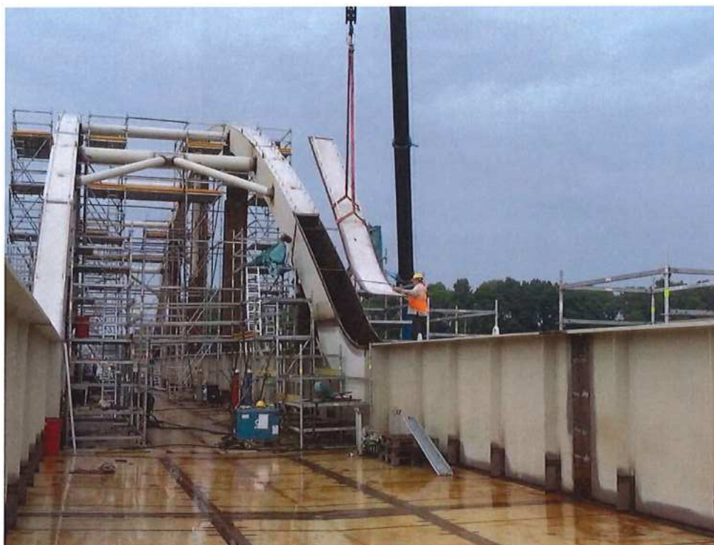
Montáž oceľovej konštrukcie mosta cez rieku Morava – SO 12-33-04
